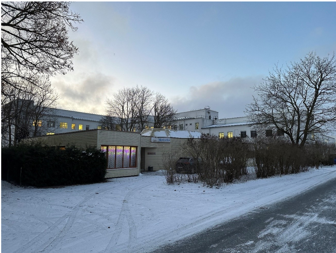
Joonis 3. Vaade lammutatavale hoonele ja uue planeeritava juurdeehituse paigale. (03.01.2024, Ketil Kaljuste)
