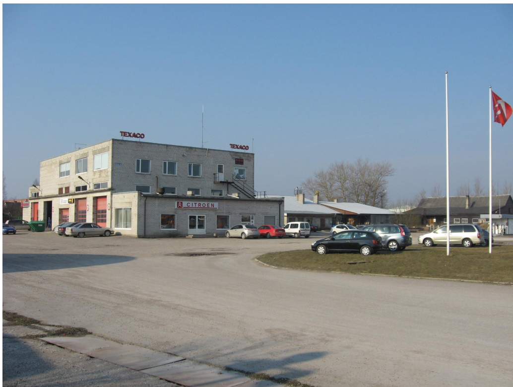
Põhja tn 53 asuv hoone, vaade kirdest
