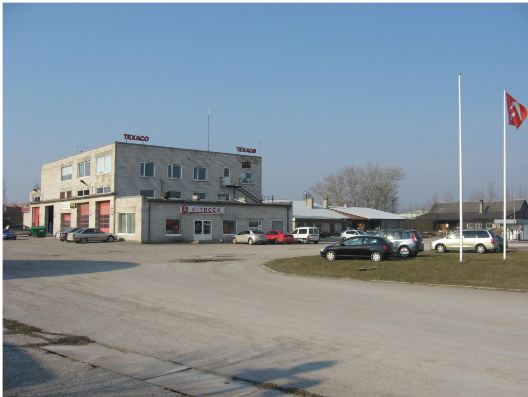
Põhja tn 53 asuv hoone, vaade kirdest
