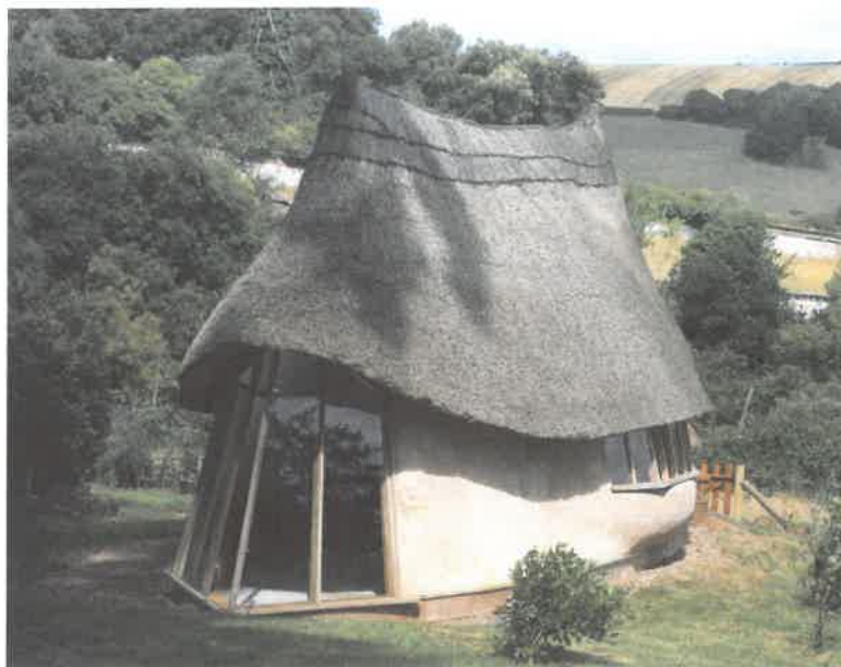
Foto 8 Moderne näide puidust krohvitud ja rookatuses majast (foto James Wines raamatust Green Architecture; arh Daivid Lea, England 1985)
