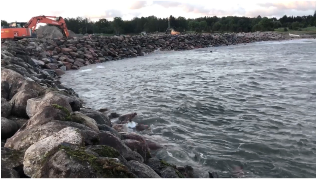
Foto 1 Vaade kaile nr 1 (Põhjakai).
