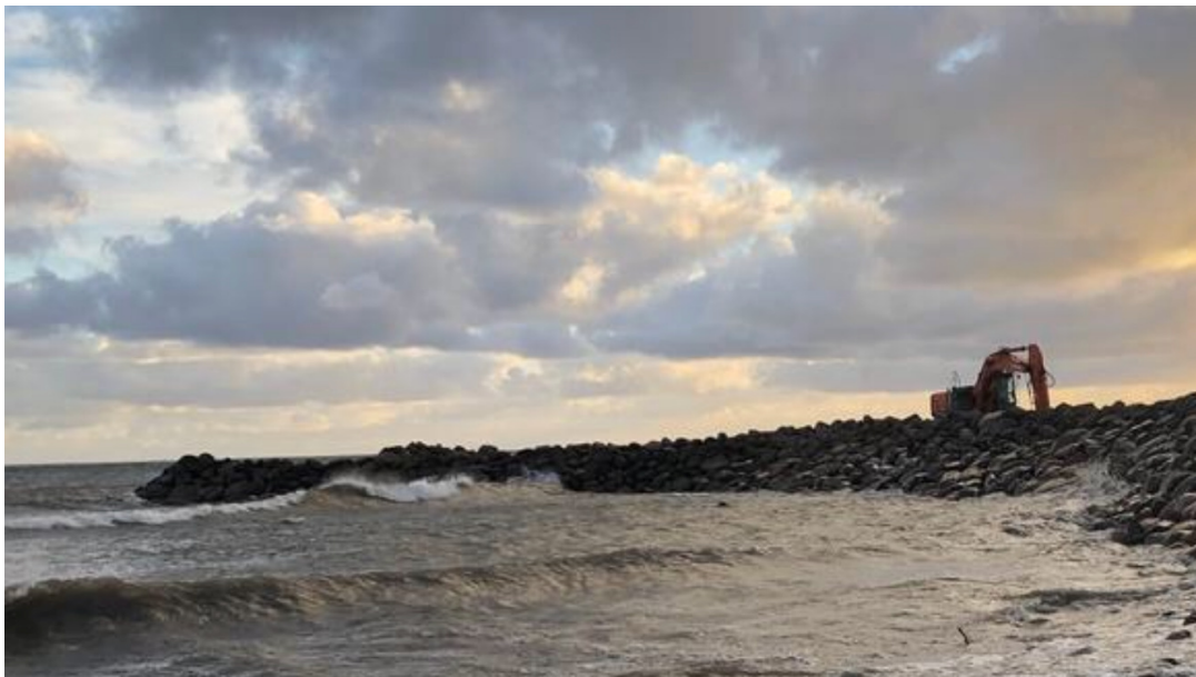
Foto 2 Vaade kaile nr 1 (Põhjakai).
