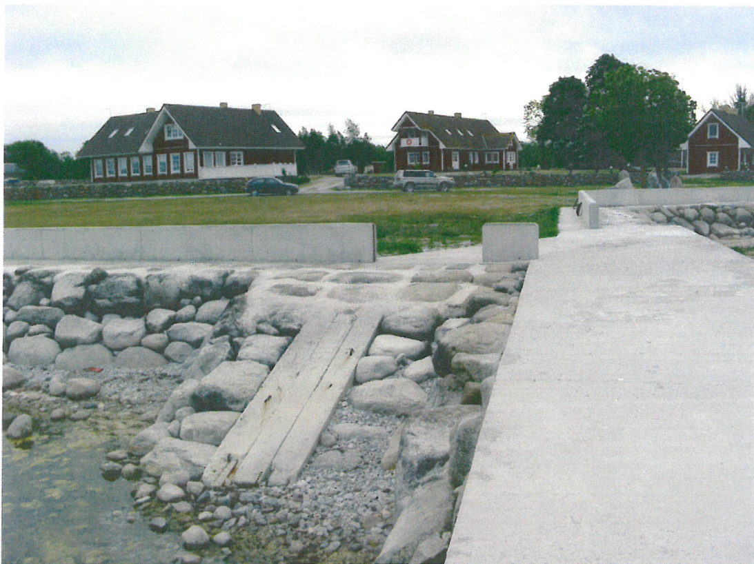
Foto 3. Kaldakindlustuse ja kivimuuli vahelises nurgas on olemas kas halvasti ehitatud või oskamatult projekteeritud (?) paadislipp – kaldtee.
