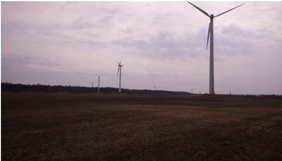
Joonis 3. Tiigi ja Sarapupõllu detailplaneeringualale 2012. aastal paigaldatud kolm tuulegeneraatorit koguvõimsusega 5,5 MW. Ees paremal Tiigi maaüksusele (27003:001:0568) jääv tuulegeneraator nr 1 (ehitisregistrikood 220534588), kõrgusega 80,2 m,. Tagaplaanil Sarapupõllu maaüksusele (27003:001:0139) jäävad tuulegeneraator nr 2 (ehitisregistrikood 220534590), kõrgusega 77,5 m ja tuulegeneraator nr 3 (ehitisregistrikood 220534591), kõrgusega 70,7 m (Liina Saar, 16.04.2018).
