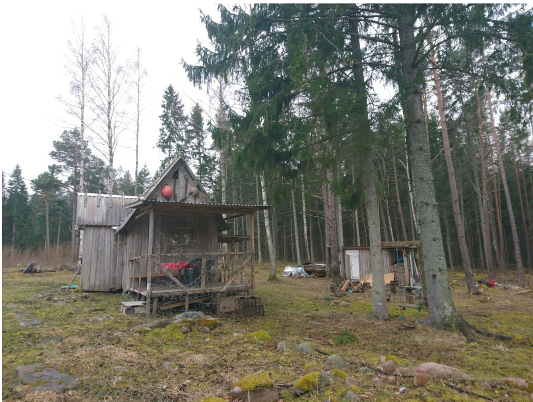
Joonis 3. Ebaseaduslikud ehitised Merikivi maaüksusel. Eespool on näha ka vanad kividest vundamendikohad. (Liis Sepp, 10.04.2019)
