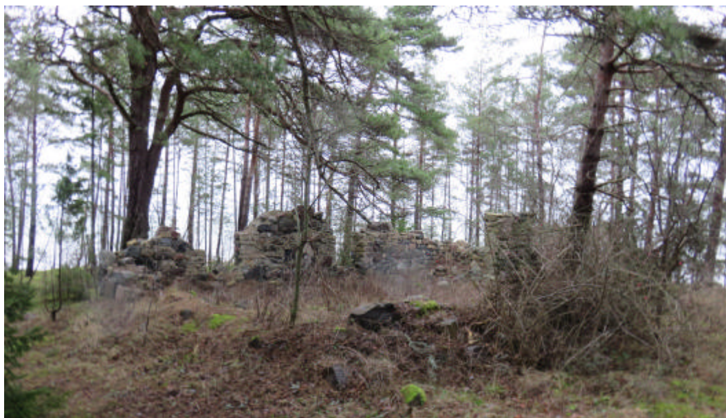
FOTO 1: Vaade Ninanuki maaüksusel vanale kordonihoone vundamendile, planeeritud põhihoone.
