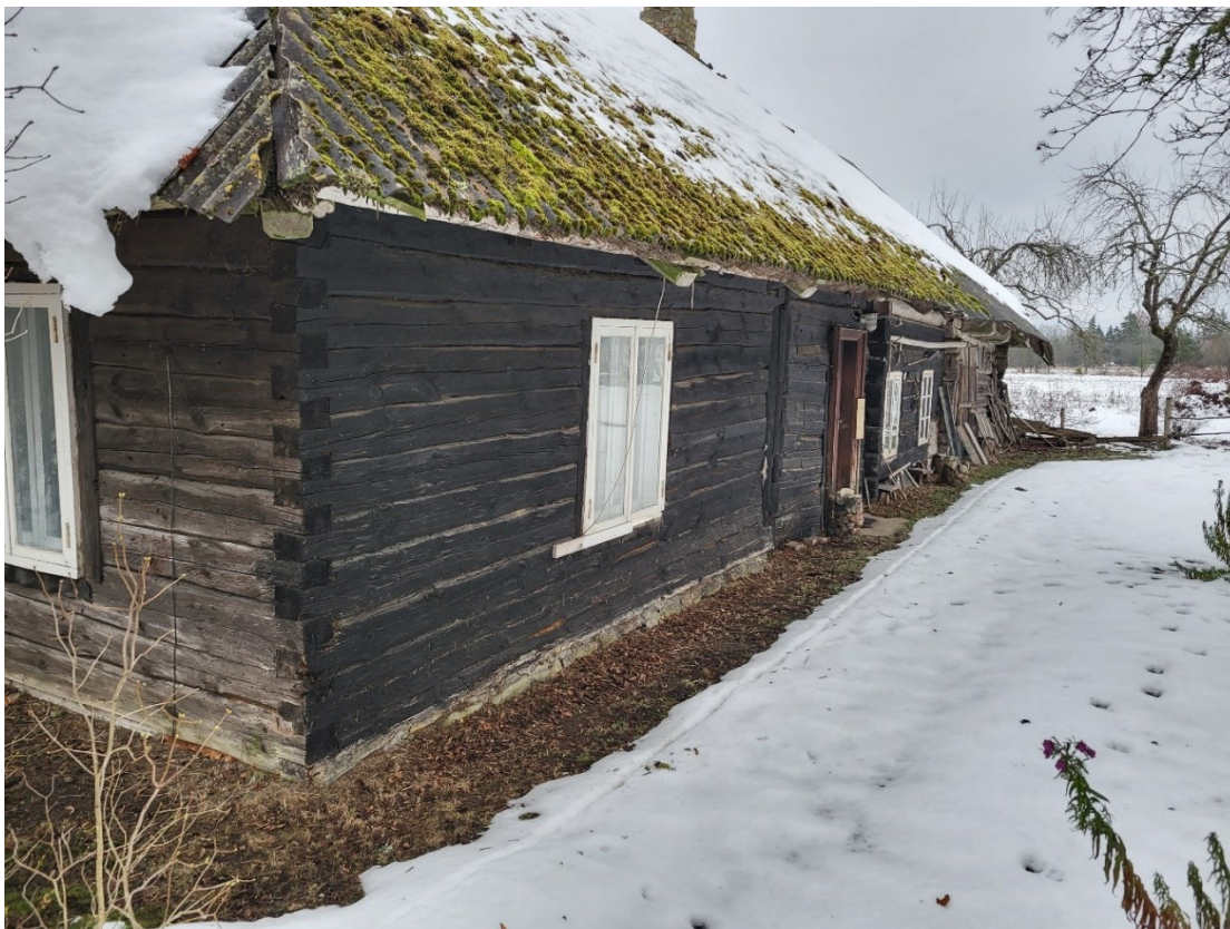
Joonis 2. Kinnistul asuv rehielamu, mis läheb lammutamisele, vaade loodest kagusse (K. Kuusk 30.11.22)
