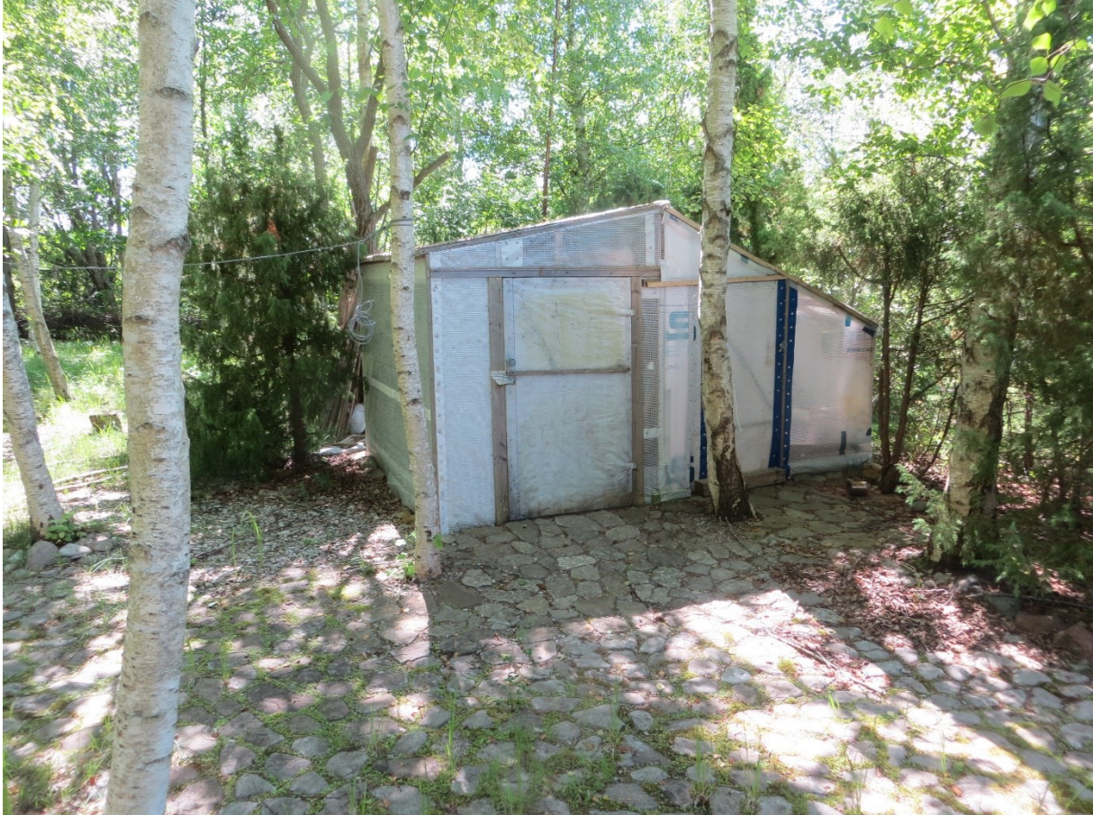
Joonis 2. Ahiste maaüksusel paiknev kergkonstruktsiooniga varjualune ja munakivisillutis selle ees (05.07.2022).
