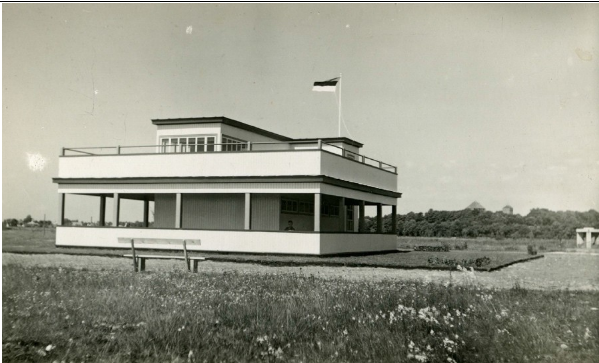
Pilt 13. 1936. a ehitatud rannahoone (E. Haamer). Paremal pool fotol päikesekell. Foto 1940. a. Allikas: Saaremaa muuseum.
