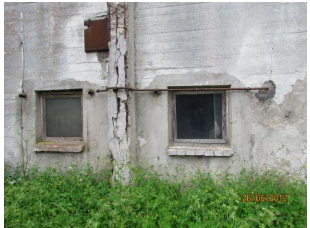
10. Hoone 1 kirdeseina uks ja aknad.
