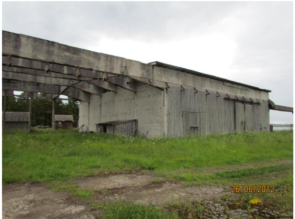
19. Hoone 2 loodepoolne vaade ja säilinud merepoolne maht.
