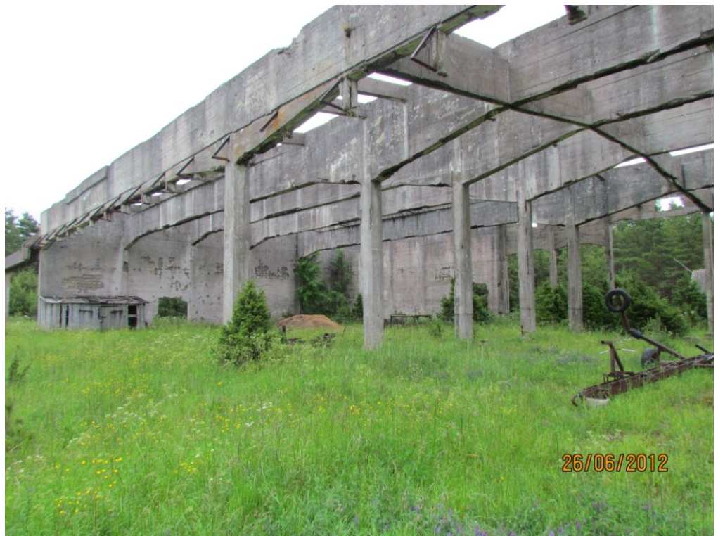
20. Hoone 2 tugikonstruktsioon, vaade kirdepoolsele osale.
